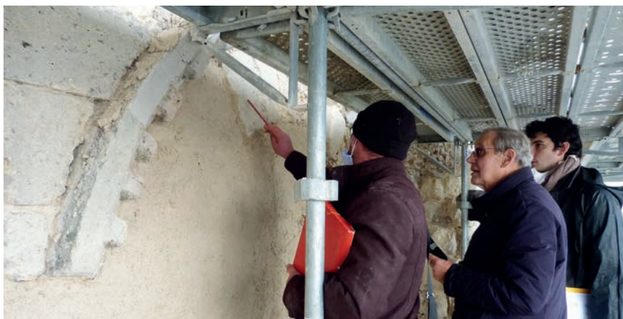
Visite de chantier avec Dimitri Dupuis l'architecte
