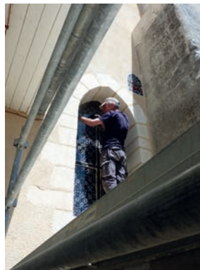
Fenêtre sud 1 er étage extérieur
