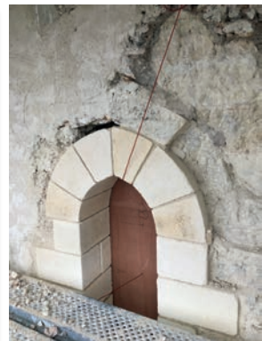
Fenêtre sud 2 me étage extérieur
